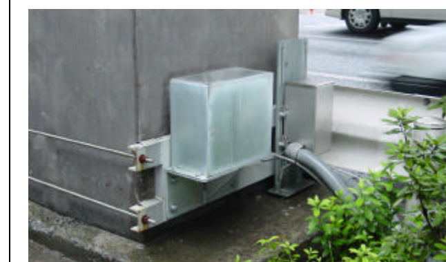
首都高速道路橋脚への適用事例
