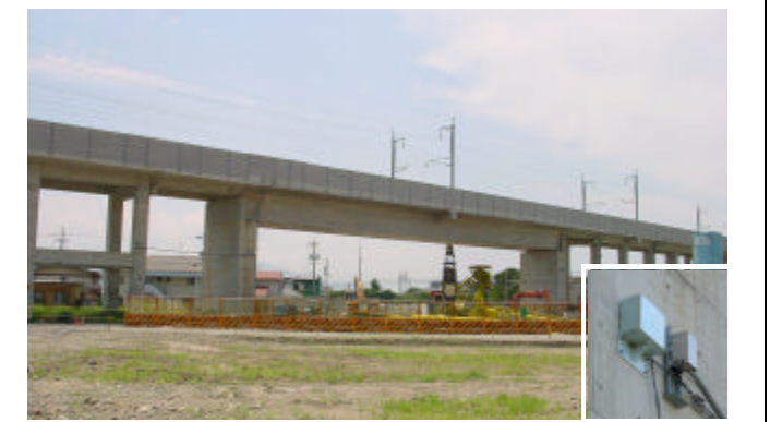
新幹線高架橋への適用事例
