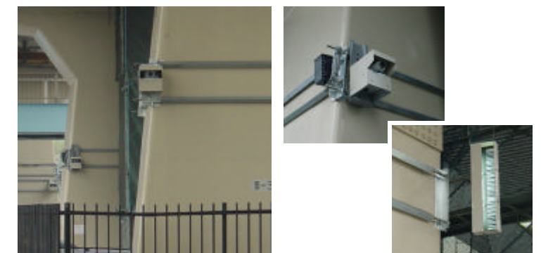
首都高速道路高架橋への適用
