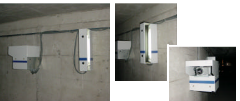
地下駅のアンダーピニング工事への適用事例
